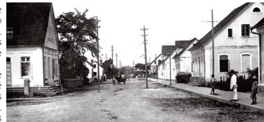
Postes, fiação e iluminação pública, um dos orgulhos na Joinville dos anos 20
