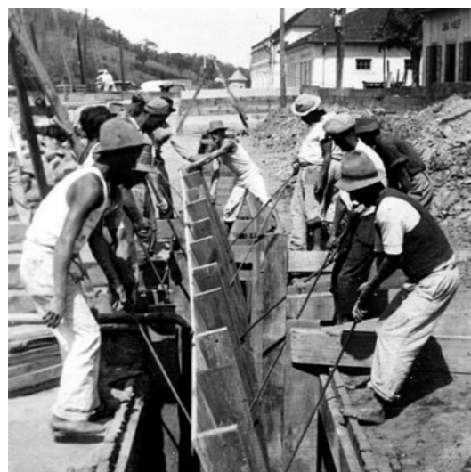
Operários trabalham nas obras do porto de Joinville, nos anos de 1940
